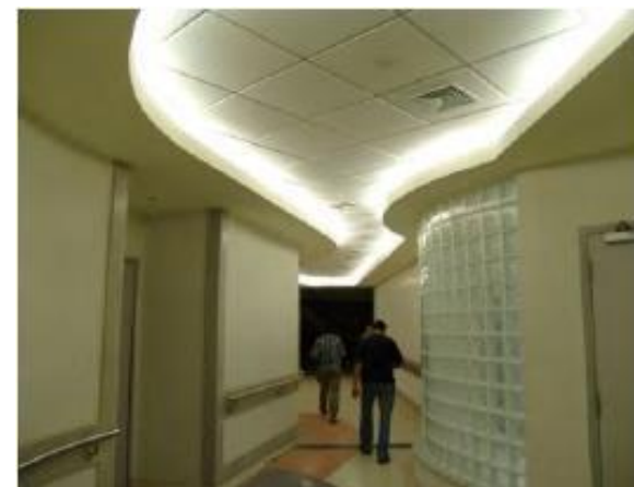
شكل يوضح إحدى الممرات التي روعي فيها الإضاءة أستخدم في السقف البلاطات الجبسة
