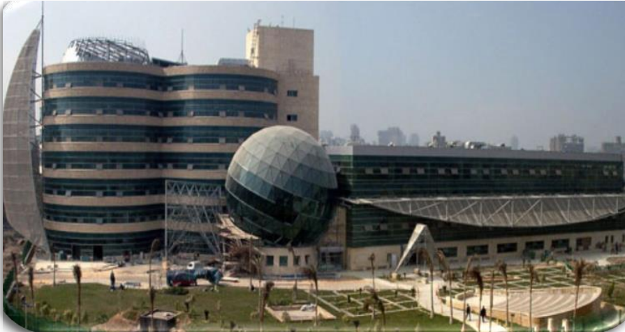
شكل يوضح التصميم هو الاستفادة بأكبر قدر من الإضاءة الطبيعية مع حجب لأشعة الشمس الضارة وفي نفس الوقت يقلل من كمية الحرارة الداخلة من جهة الشمال
