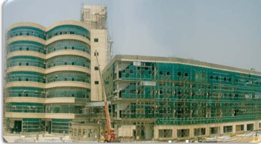
شكل يوضح الإنشاء الذي تم فيه تركيب الزجاج في الواجهات
