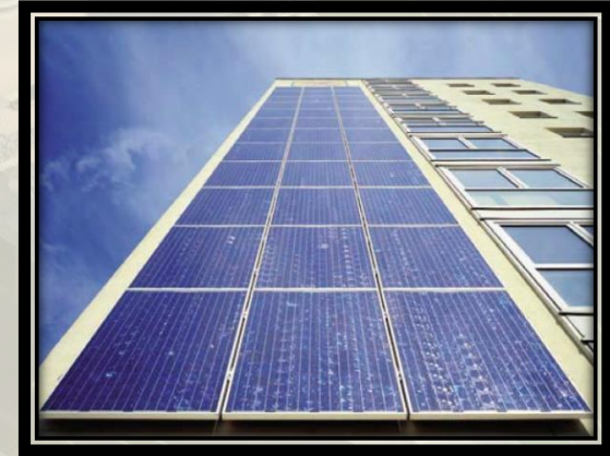
شكل ( ١.١ ) الواح الطاقة الشمسية في واجهات المباني
