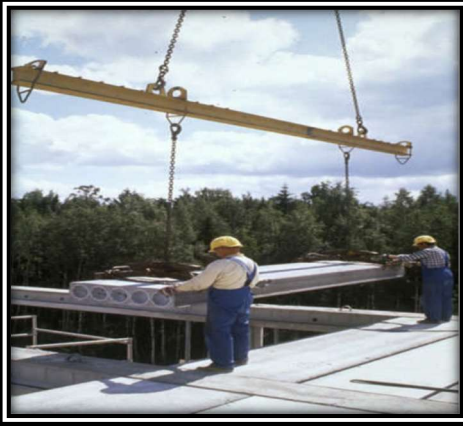
شكل يوضح تركيب البلاطات مسبقة الصنع
